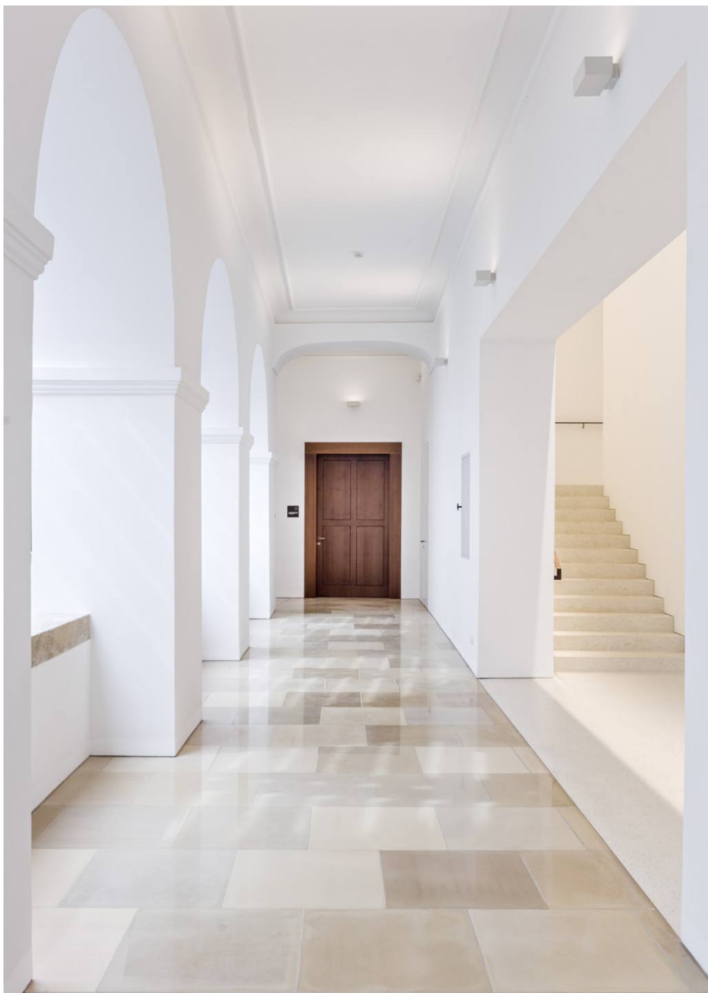
Felújított emeleti folyosó a beépített tetőtérbe vezető kortárs lépcsővel
