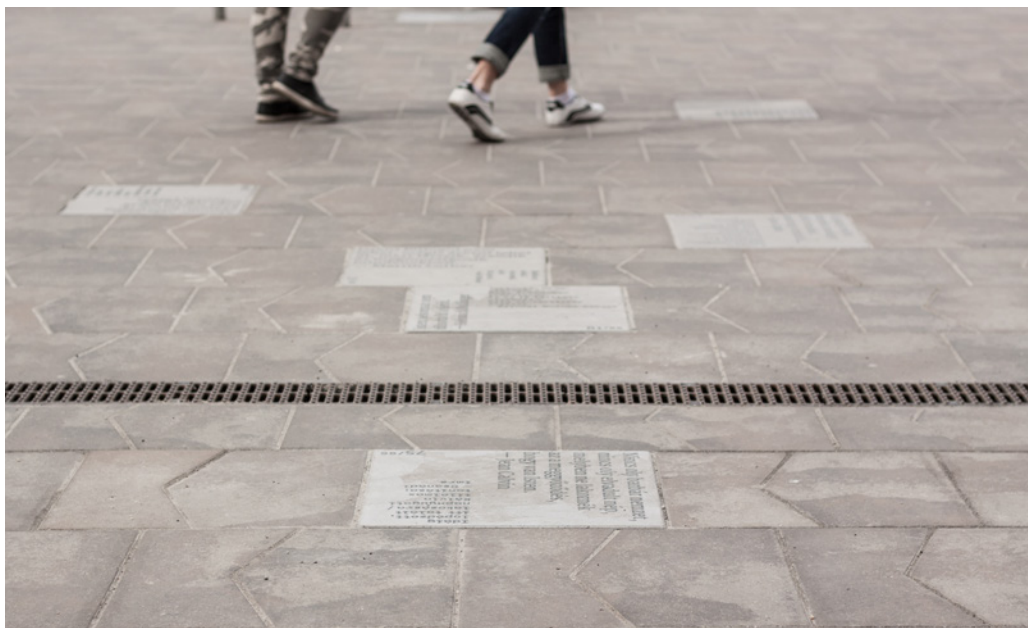
Elkészült finombeton térkövek az idéztpárokkal
