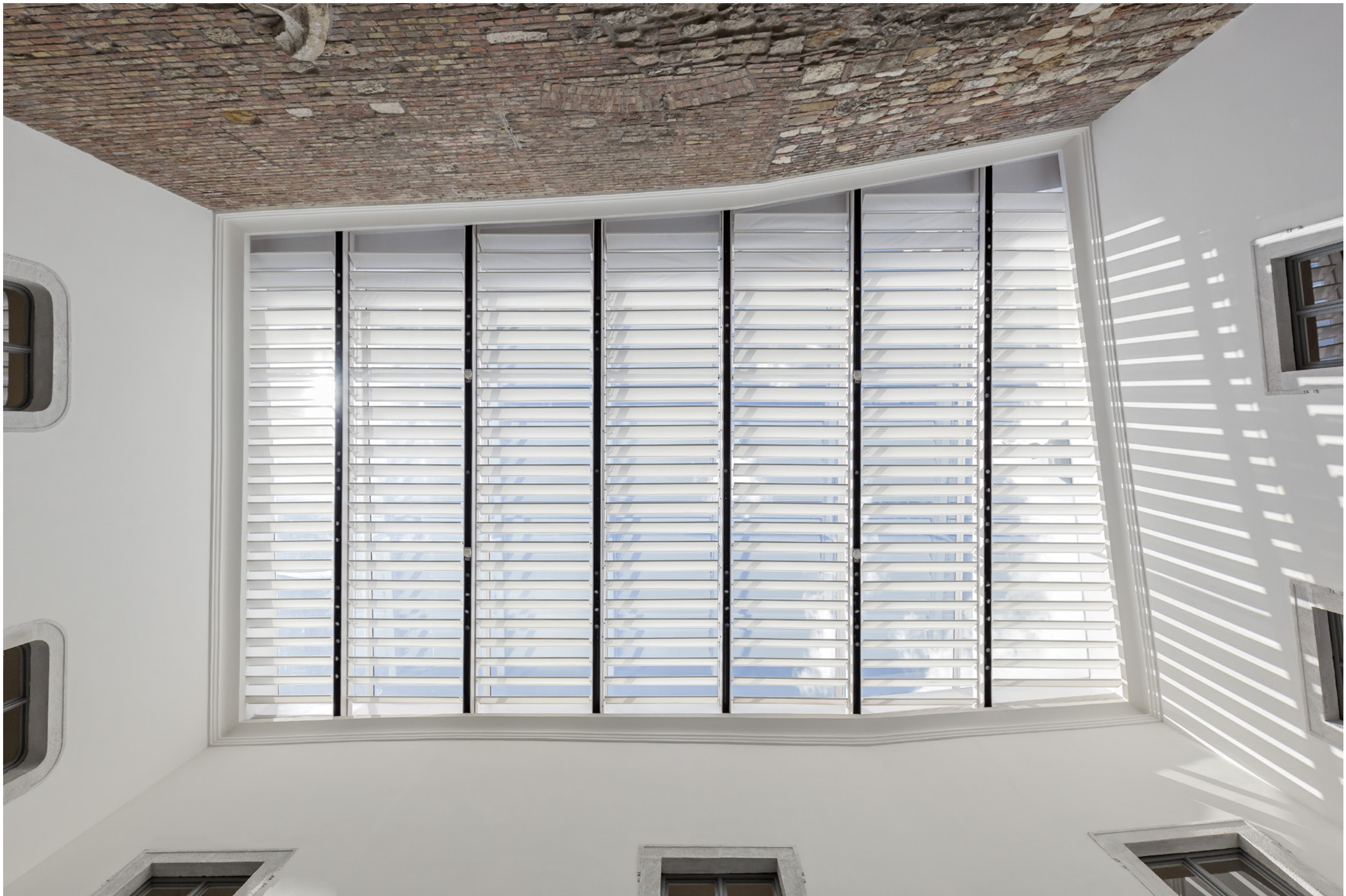
Belső udvart lefedő üvegtető
