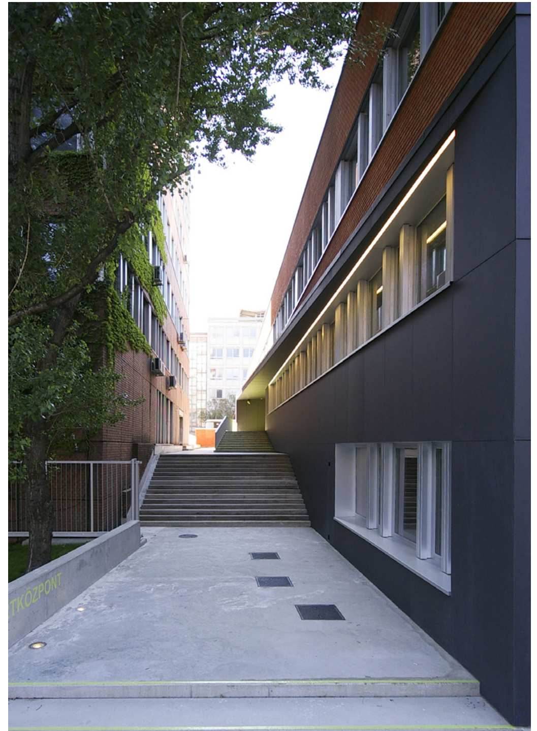
Szálcement burkolatú „protézis” jelöli a Sportközpont új főbejáratát
