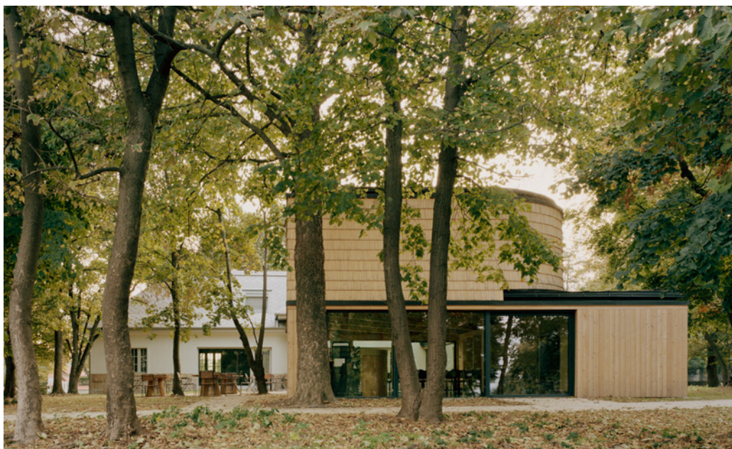
A pavilon északi homlokzata, háttérben a Sínház megújult épületével
