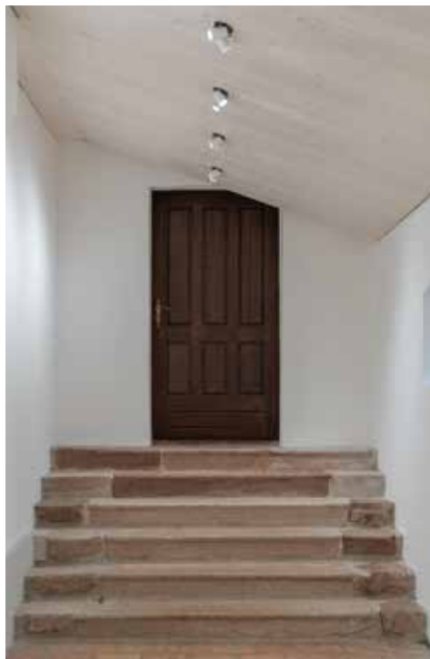
4. kép A déli folyosóról a sekrestye előterébe vezető, az egykori szentélyrekesztőnél lévő lépcső kőtömbjeit felhasználó, megtisztított lépcső, 2024. (Fotó: Biri Balázs)
