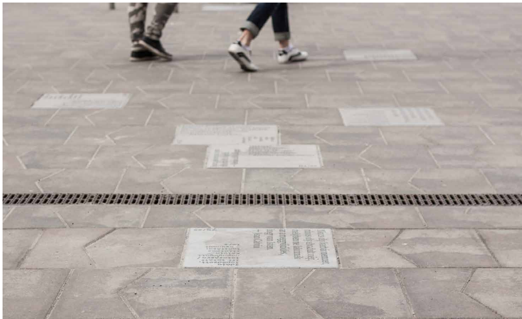
Elkészült finombeton térkövek az idéztpárokkal
